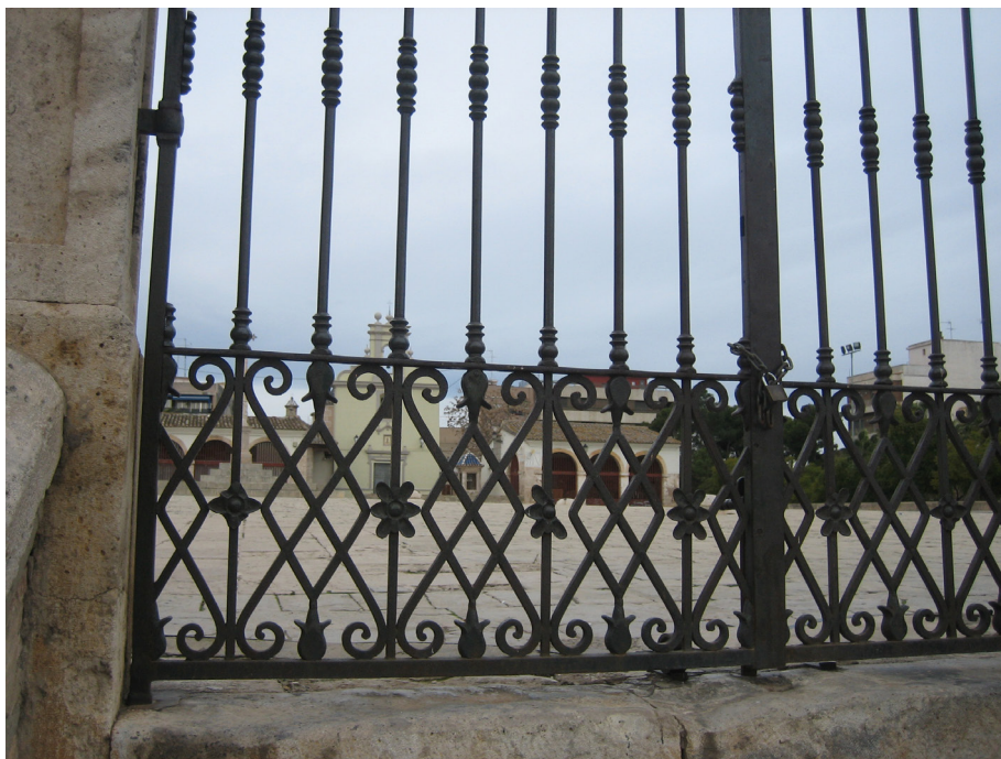
Reja que da acceso a los Silos desde la plaza de Emilio Castelar.
