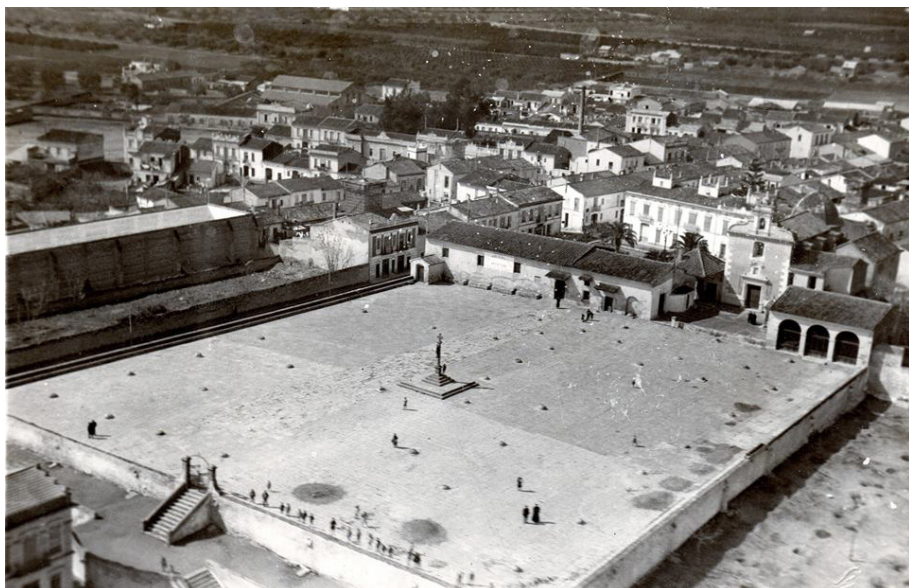
Las características y ubicación de Los Silos le hacían idóneo para ubicar un lazareto.
