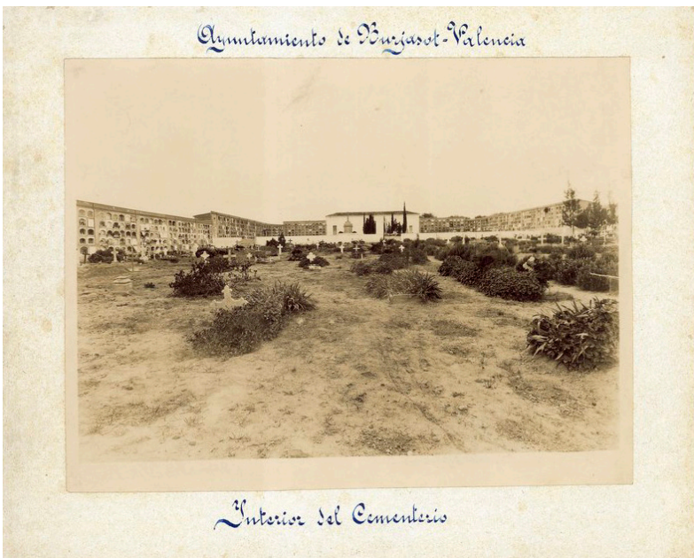
Interior del nuevo Cementerio. A.D.V.
